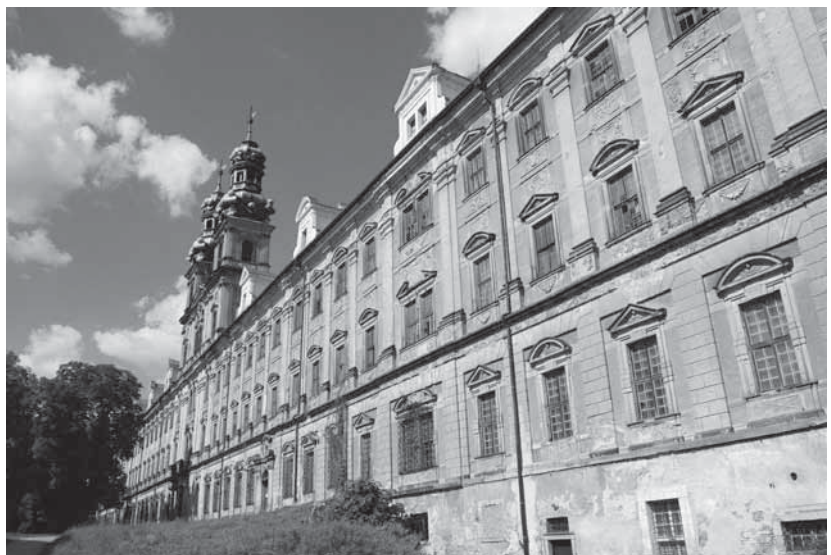
Fassade nicht „als Fassade“, vielmehr als Ereignis: Kloster Leubus Bilder: die Autorin
