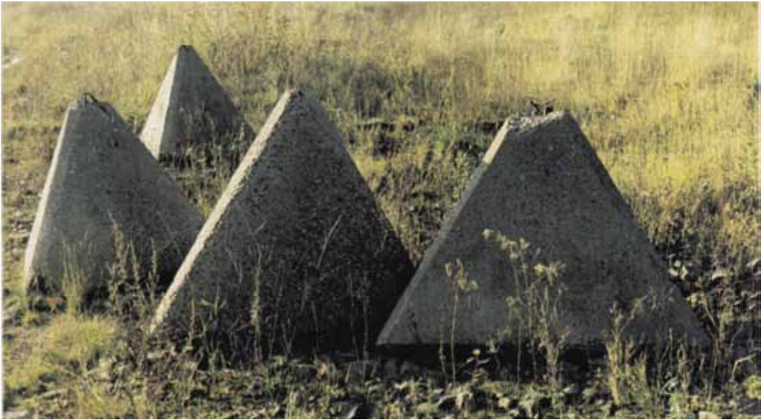
Erratisch, hässlich bis lächerlich wie alles wehrtechnische Beginnen – im Rückblick: Ladislav Solc, Panzersperren in der ehemaligen Grenzzone bei Heiligkreuz, Egerland
